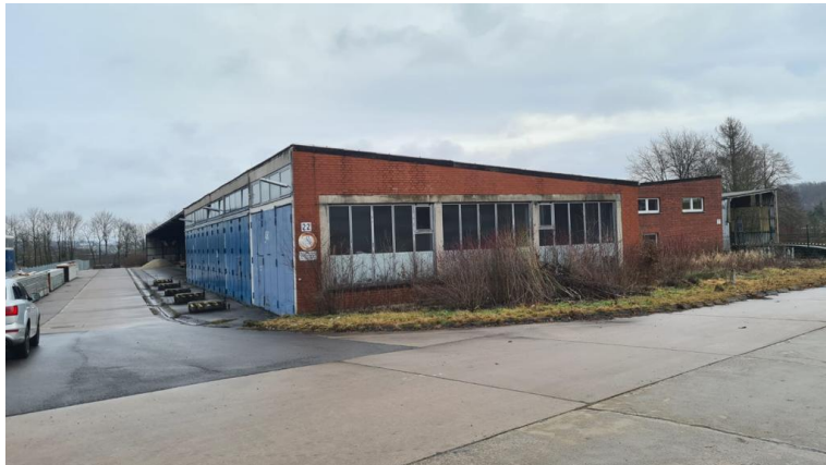
So sah das Gebäude vor der Sanierung aus. Foto: privat
